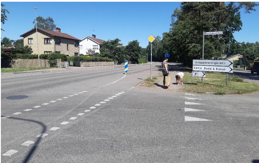
Figur 28. Havsbadsvägen har en helt annan utformning och bredd, än de anslutande gatorna Reningsverksvägen och Spårgatan.
